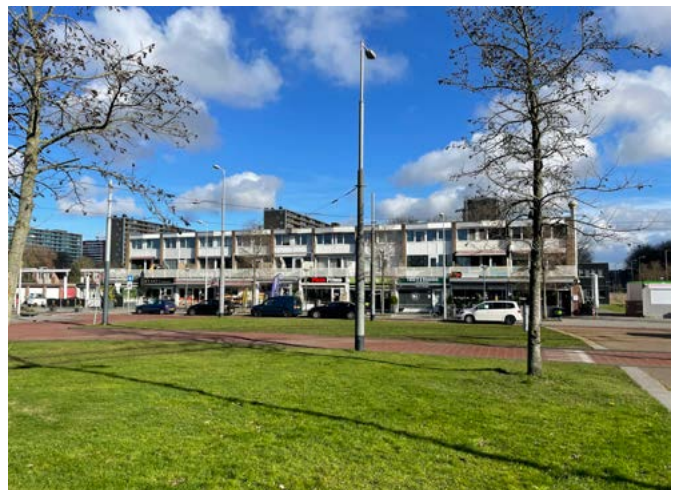
Afbeelding 4: gevelaanzicht aan het plein
