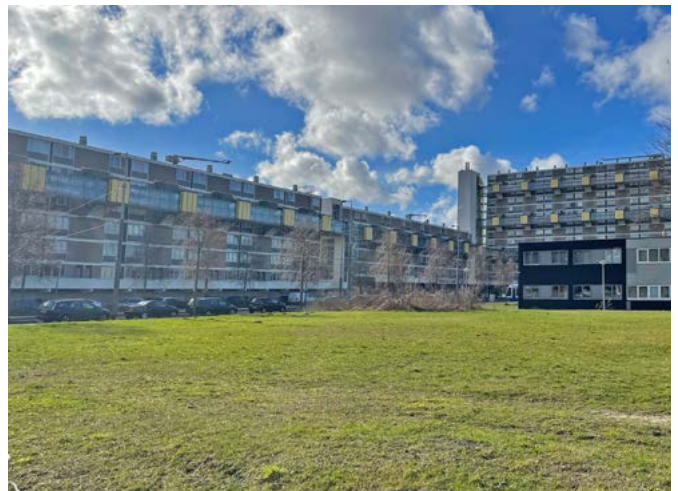
Afbeelding 3: braakliggende ruimte aan het Dijkgraafplein
